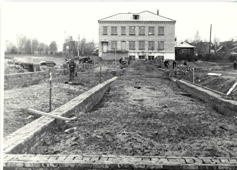
Строительство лечебного корпуса в п. Ува
